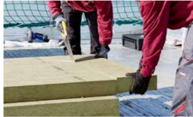
Die Dämmplatten lassen sich leicht zuschneiden.
