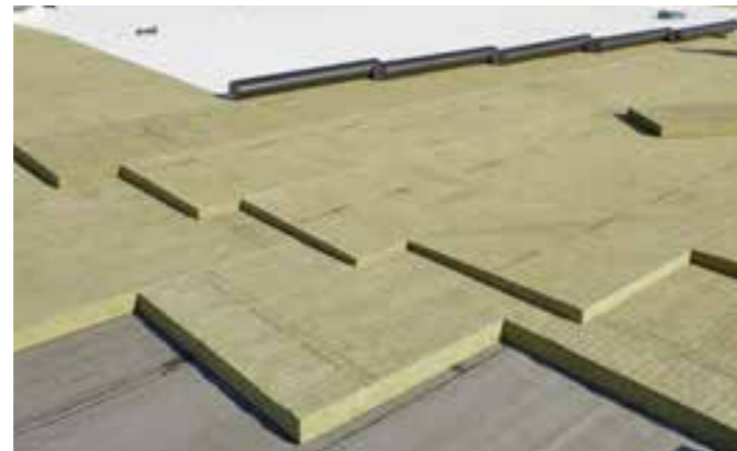
Die Verlegung der Dämmplatten erfolgt im Verband.
