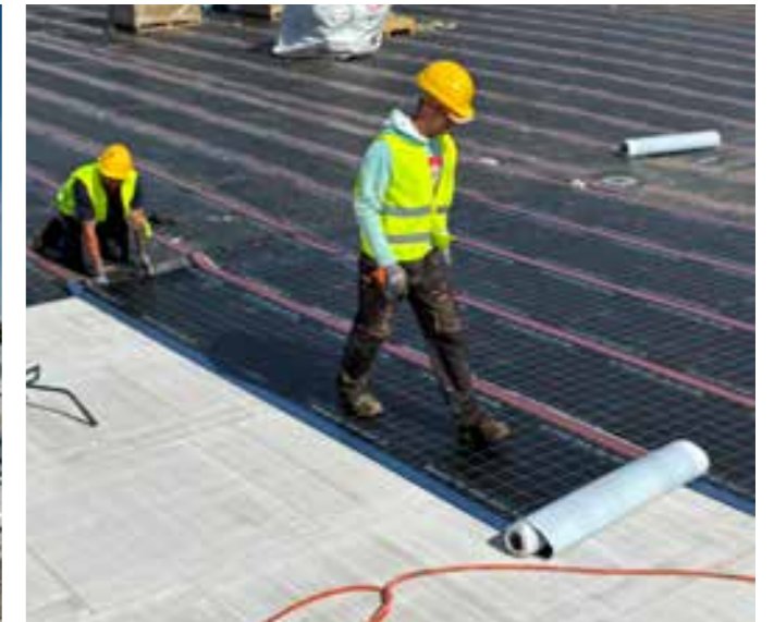
Dachaufbau verklebt
