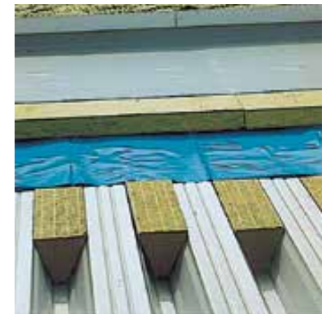
Brandschutz-Profilfüller zum Lastabtrag
