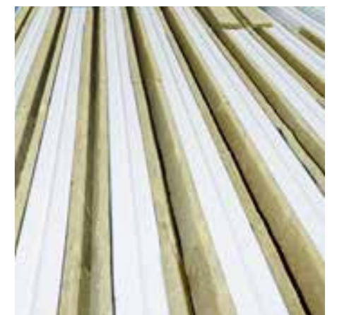
Einlegen von Akustik-Profilfüllern in Trapezprofile
