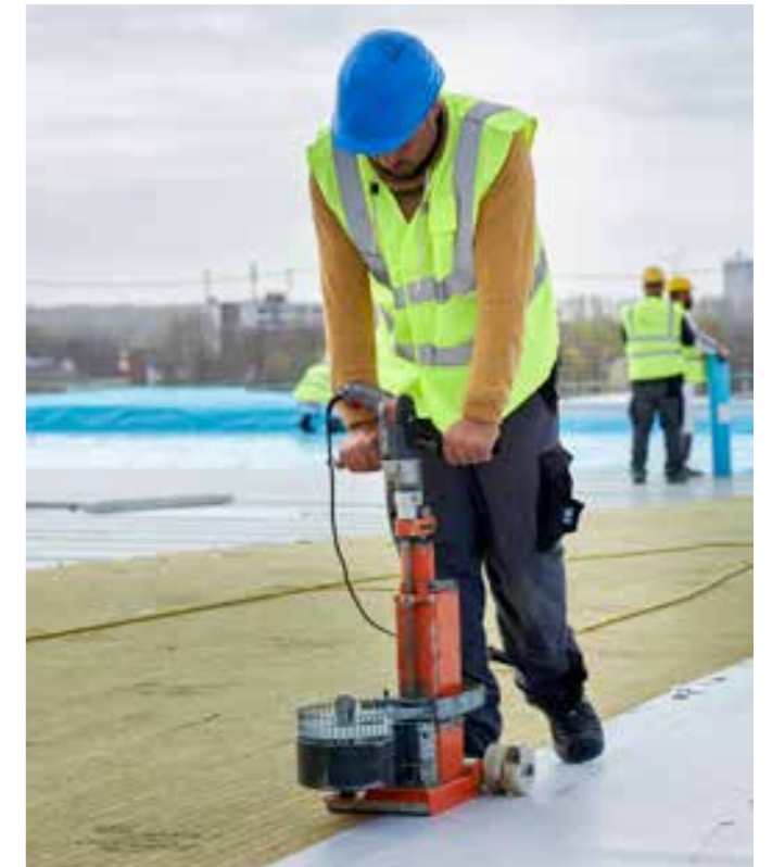
Dachaufbau mechanisch befestigt
