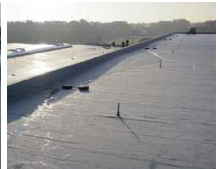
Punktentwässerung entlang der Attika
