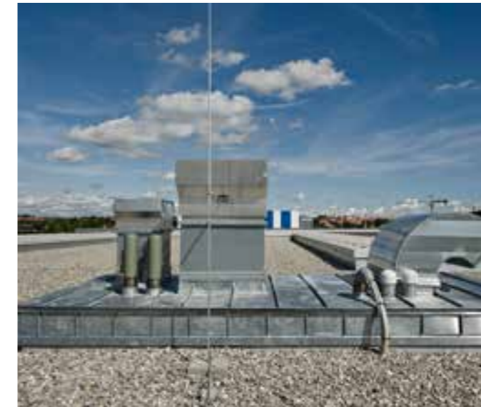
Dachaufbau lose verlegt mit Auflast
