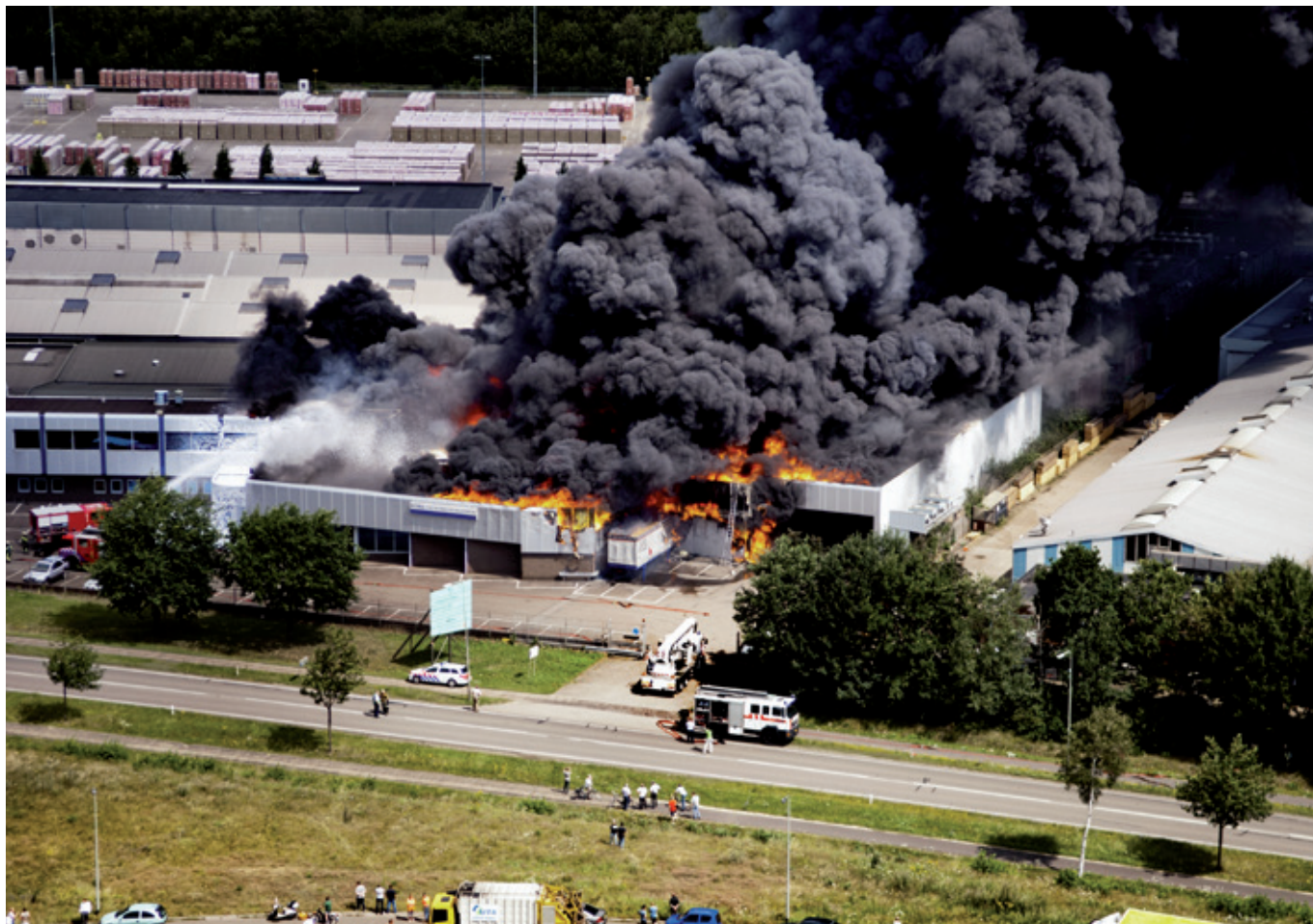
Uitslaande brand met brandbare isolatie (begonnen tijdens werkzaamheden op het dak) bij KOMA Koeltechniek
