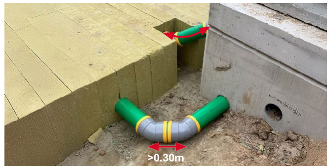
Foto 3: Aansluiting put en Rockflow
