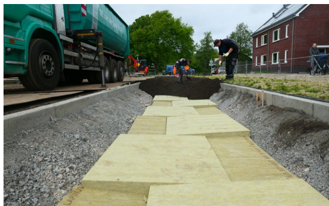
Praktijkvoorbeeld Rockflow klimaatwadi aanleg nieuwe woonwijk
