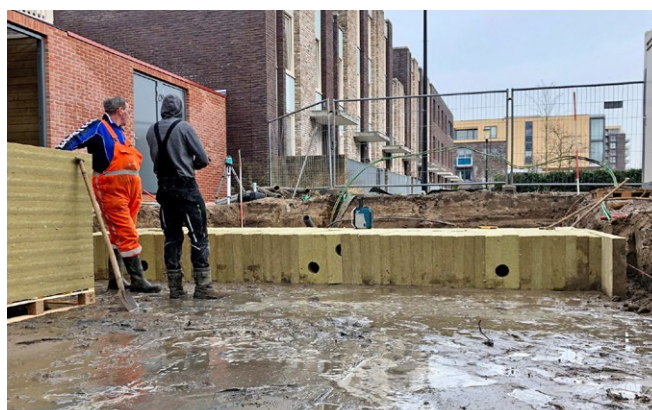
Praktijkvoorbeeld drainage bij hoog grondwaterstand
