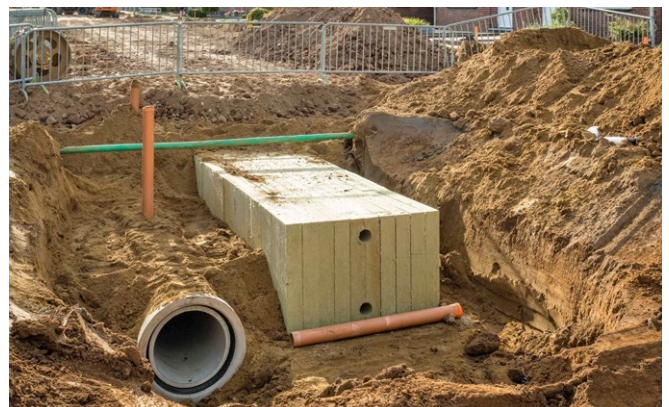
Praktijkvoorbeeld lijnfiltratie Maasbracht
