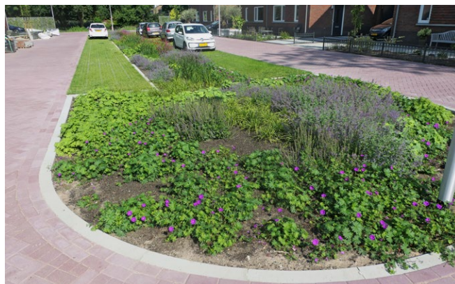
Praktijkvoorbeeld Rockflow klimaatwadi aanleg nieuwe woonwijk
